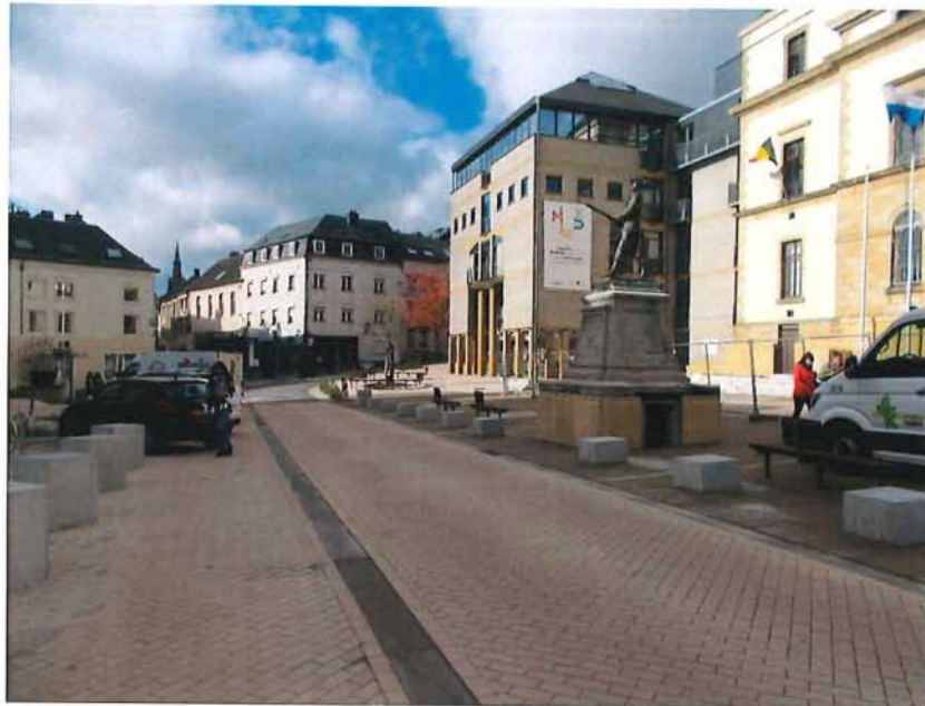
Figure 43 : Chantier en cours rue Paul Reuter (Photo : DR(EA) 2 M)
