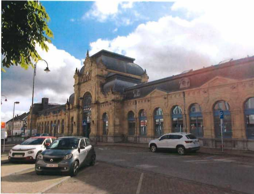
Figure 57 : Gare d'Arlon (Photo : DR(EA) 2 M)
