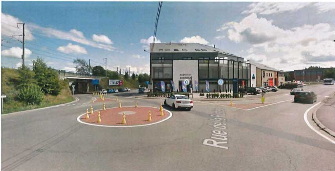
Figure 21 : entrée de ville n°5 à la Posterie (source : Google Street view)
